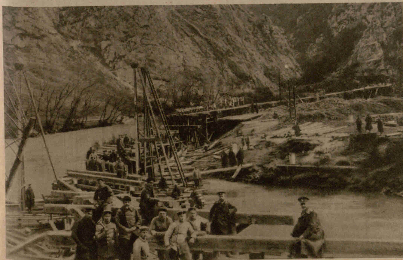
Vom Balkankriegsschauplatz. Deutsche und bulgarische Truppen beim Wiederaufbau einer von den Serben gesprengten Eisenbahnbrücke
