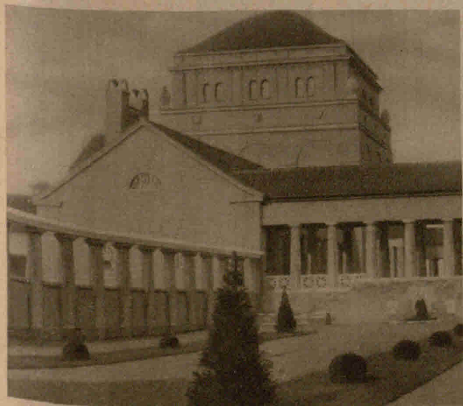
Das Krematorium Halle a. S. wurde soeben in Betrieb genommen
