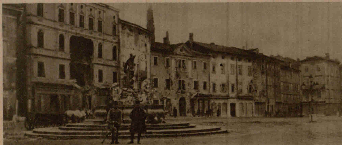
Der Hauptplatz von Gërz mit den durch die italienische Artillerie zerstörten Häusern
