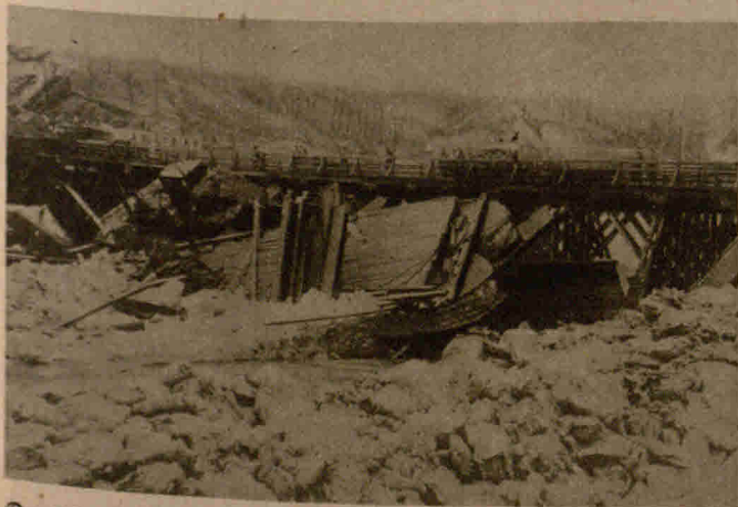
Durch starkes Eistreiben wurde an die Hohenzollernbrücke in Kowno das Gerippe eines Dampfers getrieben, der seinerzeit von den Russen verbrannt worden ist
