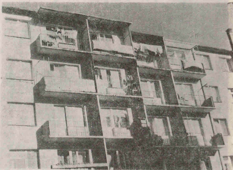
Budynek przy ul. Pułaskiego 42/46 elewacje tylne
