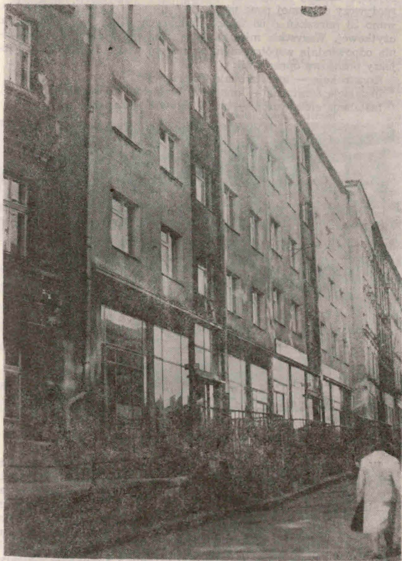
Budynek przy ul. Pułaskiego 42/46 widok od strony ulicy
