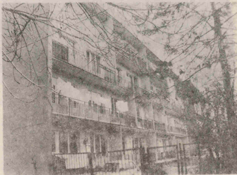
Budynki przy ul. Ofiar Oświęcimskich 9—13. Elewacje tylne
