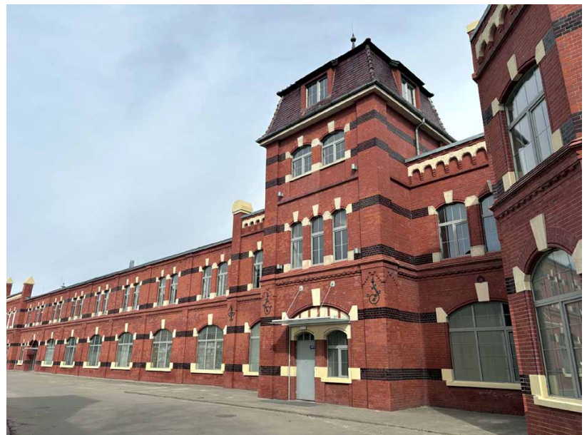
Zachowane do dziś skrzydło dawnej fabryki Rinkela, po wojnie Zakłady Przemysłu Lniarskiego „Len”. W miejscu hal fabrycznych dziś znajduje się centrum handlowe oraz Kaufland
