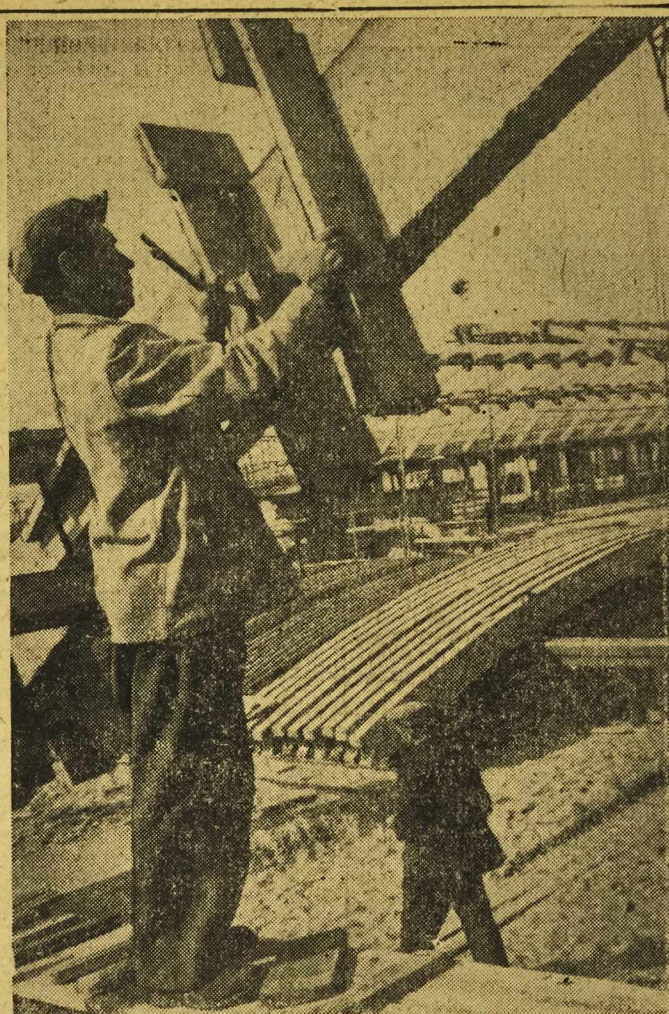
Stosownie należy się nazwa „Gigant” wielkiej budowy Planu 6-letniego, cegielni w Zielonce. Na zdjęciu — Tadeusz Kilak z brzo- gady Banaszką, która osiąga 220 proc. normy przy montowaniu konstrukcji betonowych hali produkcyjnej.
