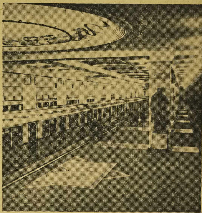
Moskiewskie metro słynie ze swego piękna na cały świat. Na zdjęciu stacja Izmailowska moskiewskiego metra im. L. M. Kaganowicza. Polscy inżynierowie korzystają będą przy budowie metra w Warszawie z doświadczeń i wzorów radzieckich.
