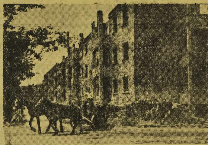
Na zdjęciu widzimy jeden z bloków przy ul. Orzeszkowej, remontowanych staraniem Zakładu Osiedli Robotniczych. Część z nich została już wykończona i zamieszkała, część zaś w niedługim czasie oddana będzie do użytku wrocławskiego świata pracy.
