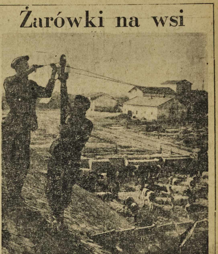
Elektryfikacja wsi postępuje szybko naprzód. W Państwowych Gospodarstwach Rolnych Wilanów doprowadzono prąd do wszystkich budynków gospodarczych. Na zdjęciu — grupa techniczna przeciąga przewody do obór i stajen. Foto CAF
