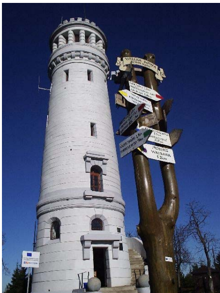
Wieża po remoncie. Fot.: Tomasz Śnieżek.
