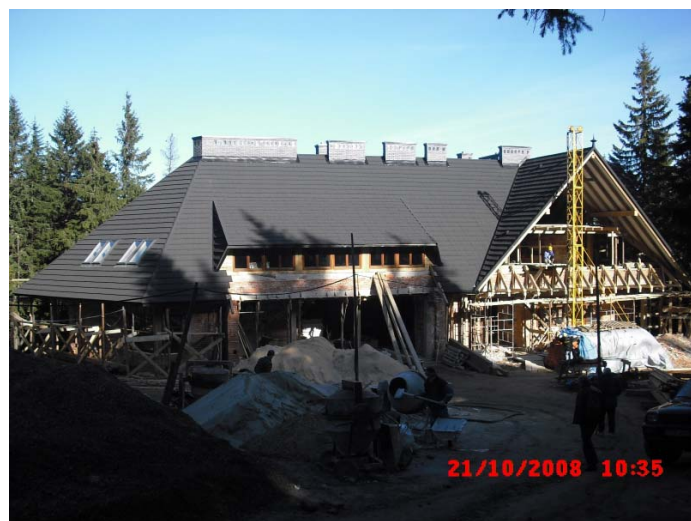
Postęp. Fot. Mariusz Szewczyk (nadzorujący budowę z ramienia s-ki PTTK KARPATY)
