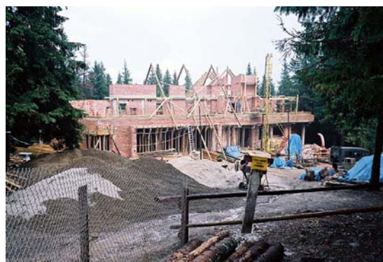
Budowa z bliska
