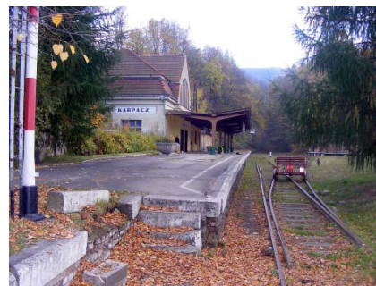
Dworzec kolejowy w Karpaczu
