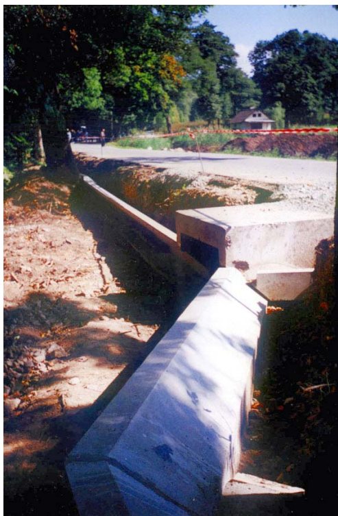
Przejście dla płazów pod jezdnią ruchliwej drogi przy zbiorniku reten- cyjnym Czerwona Woda – otulina PN Gór Stołowych
