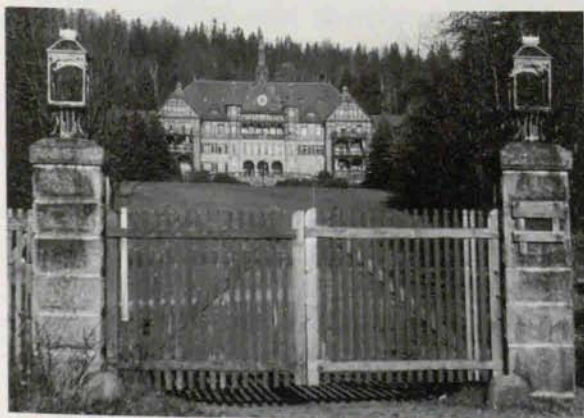
3. Budynek sanatorium Wysoka Łąka w Kowarach
