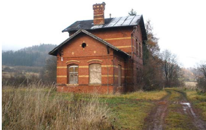
Budynek dawnej stacji kolejowej Okrzeszyn; z lewej Buczak
