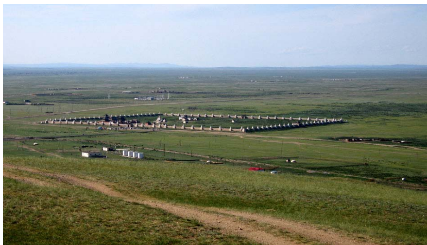
Ogólny widok Erdenedzuu chijd, za: pl.wikipedia.org/wiki/Erdenedzuu_chijd
