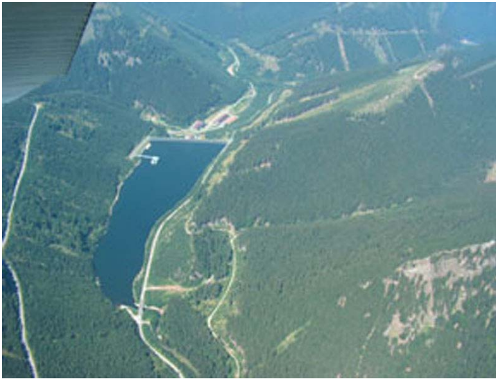
Dolny zbiornik. Fot. www.casopisstavebnictvi.cz
