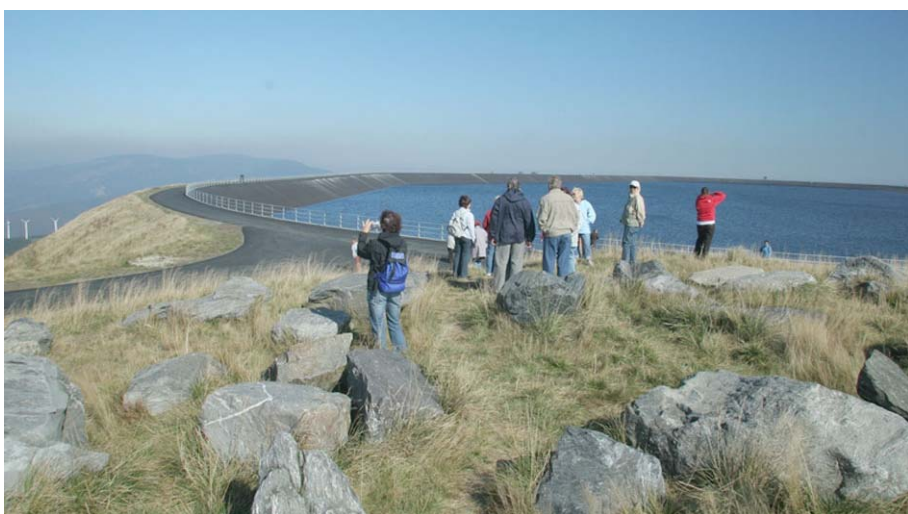
Turyści przy górnym zbiorniku. Fot. www.casopisstavebnictvi.cz
