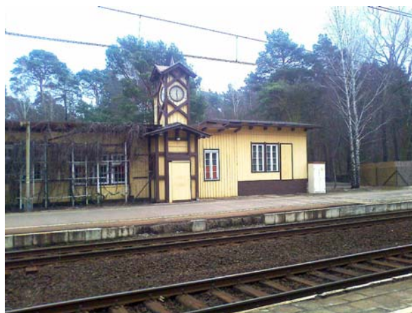
Budynek dworca kolejowego
