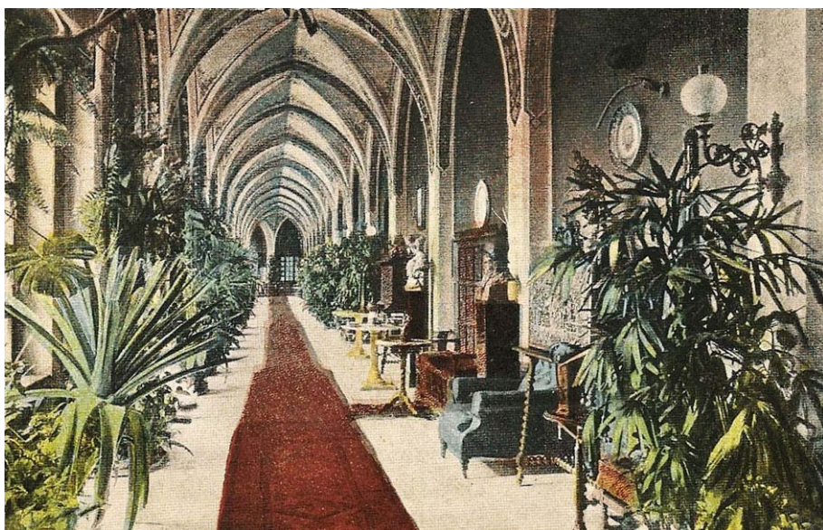
Wnętrze pałacu na przedwojennej widokówce
