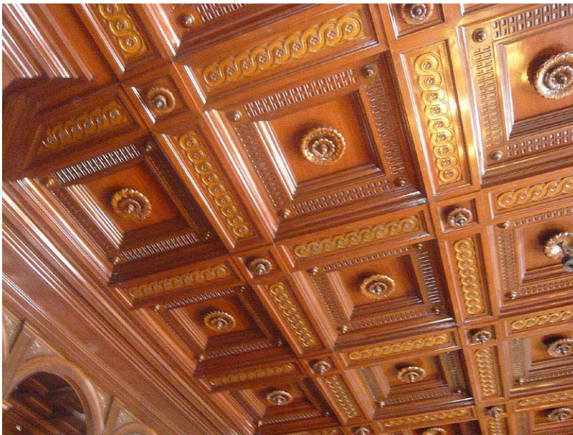
Piękny strop kasetonowy w hallu zamku
