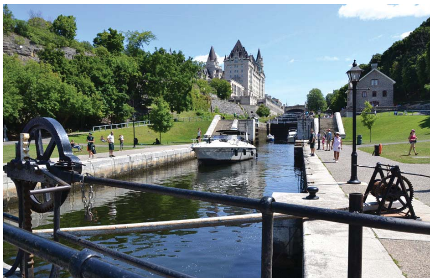
Śluzy od strony dolnej wody; w głębi po prawej budynek Intendentury, po lewej Château Laurier.
