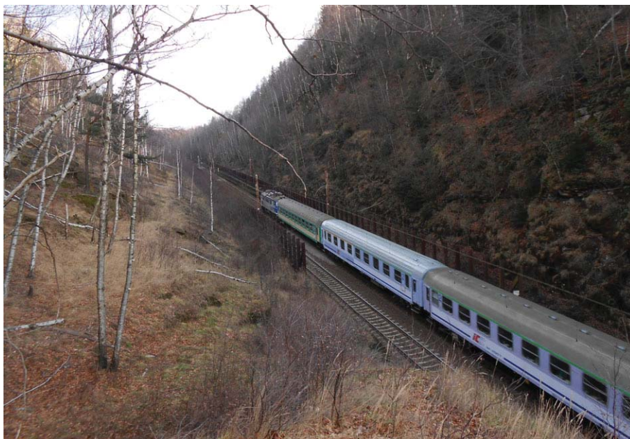
Przekop linii kolejowej między zboczami Brzezinki (z lewej) i Kamiennej Góry (z prawej) w miejscu dawnego tunelu
