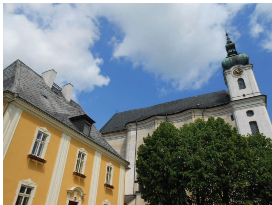
Dachy historycznych budowli pokrywa łupek
