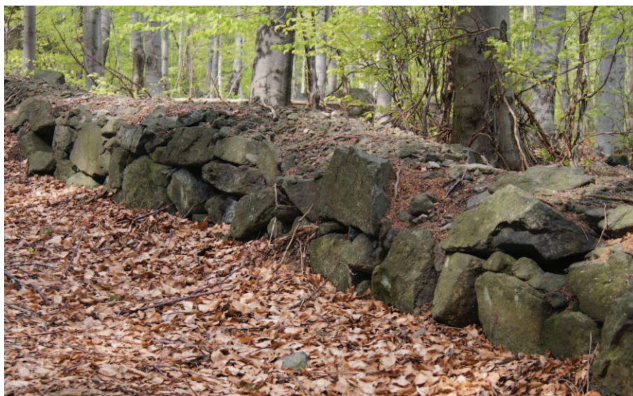
Konstrukcja muru z dopasowanych głazów (zagroda nr 8)
