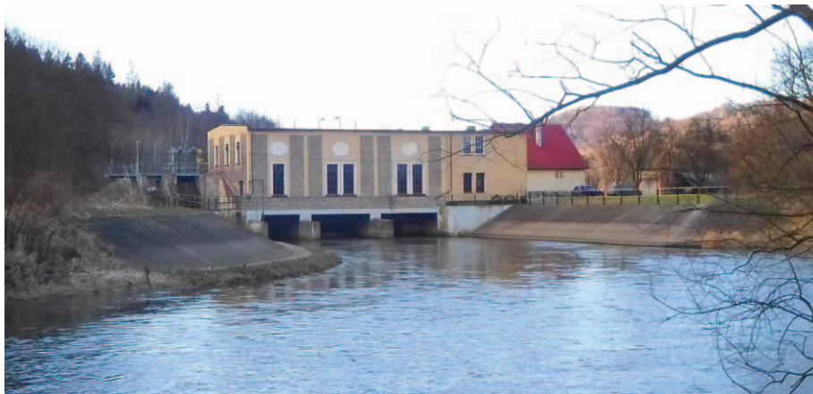
Elektrownia „Pilchowice II”
