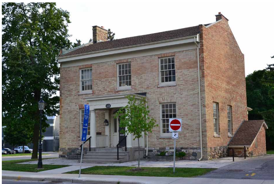
Jeden z najstarszych budynków w London (z 1838 r.) przy Ridout Street
