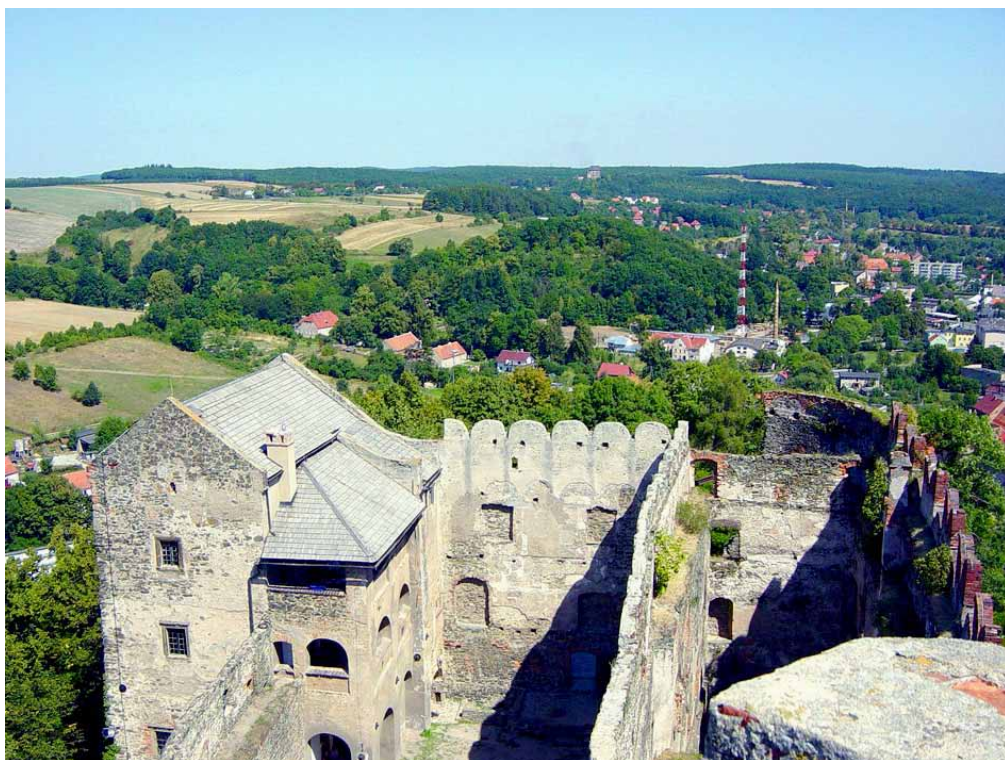
Widok z wieży w kierunku Zamku Świny
