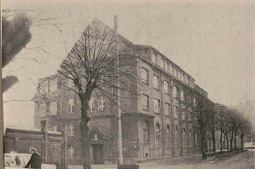
Siedziba I LO przy ul. Budowlanej.
