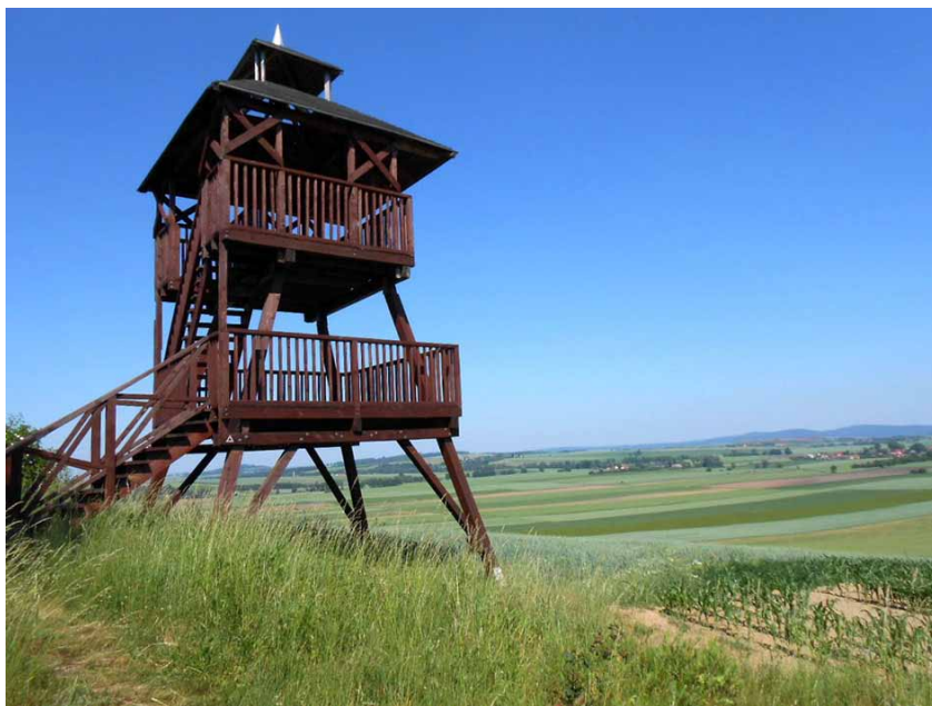
Wieża widokowa na Kawiej Górze
