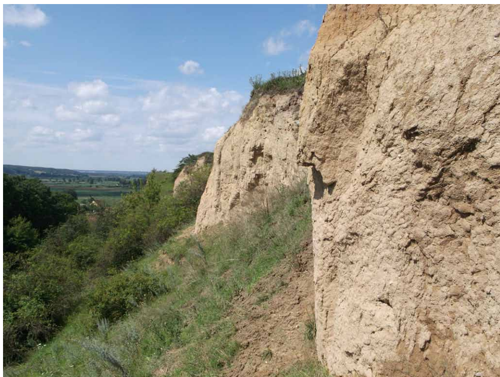
Ściany „zamkowej grani”
