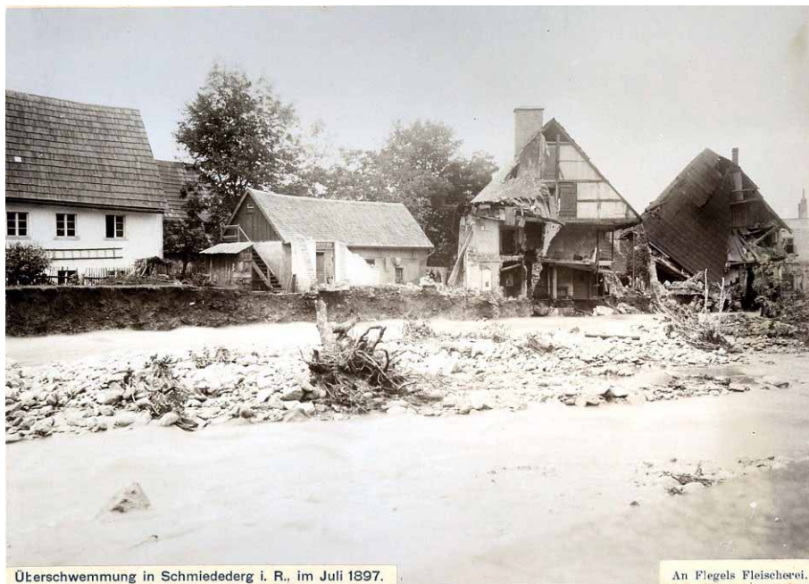
Zniszczenia przy sklepie mięsny pana Flegela w Kowarach po powodzi z 29 na 30 lipca 1897 r. (autor: P. Fisher; źródło: zdjęcie z kolekcji Muzeum Śląskiego w Görlitz)
