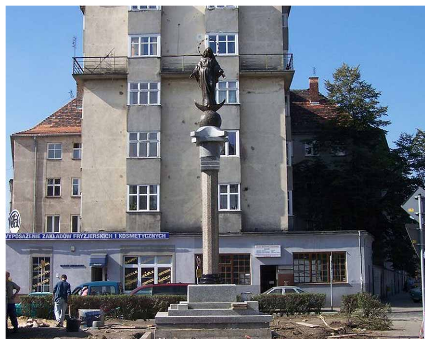
Kolumna w budowie (fot. pako45)
