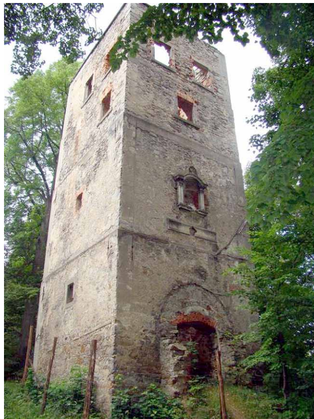
Obecny wygląd wieży w ruinie
