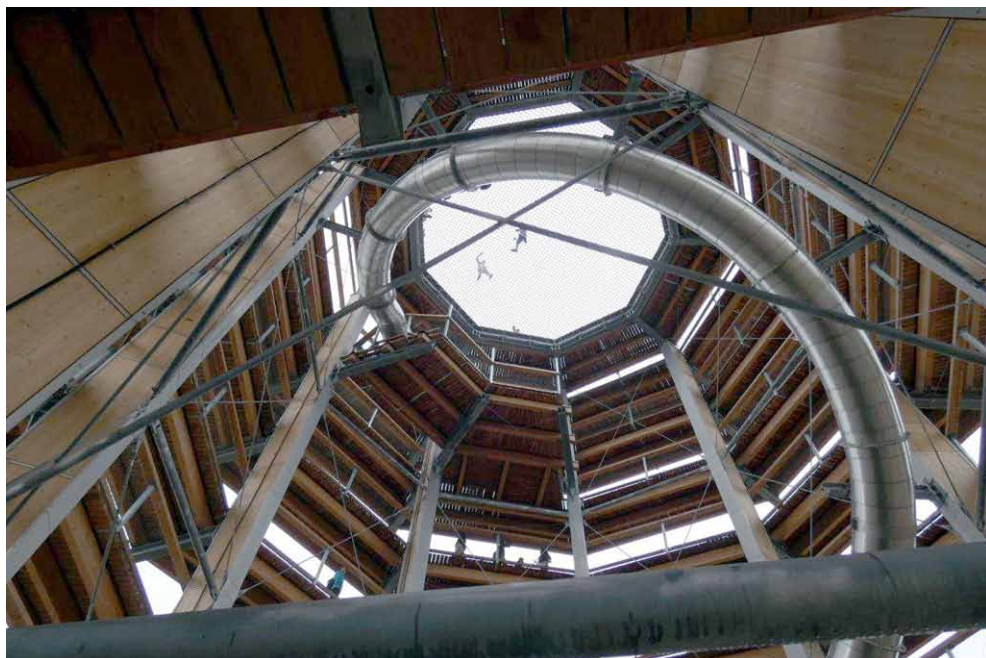
Wieża od dołu z widokiem na siatkę
