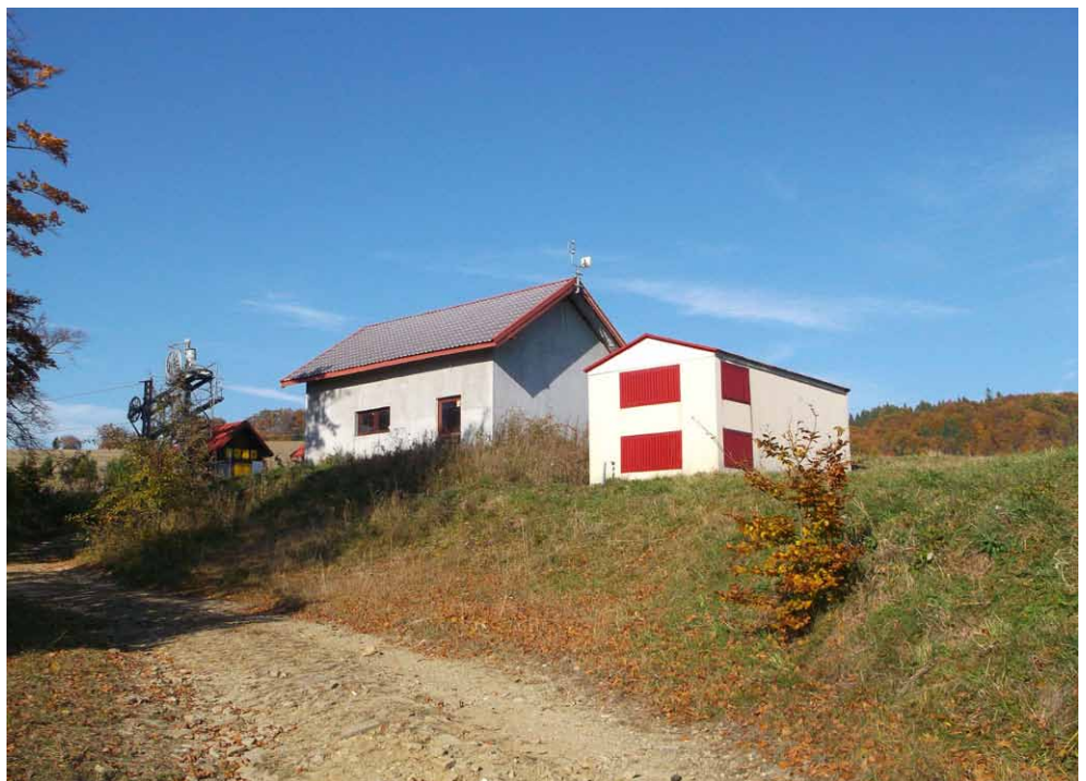
Budownictwo „regionalne” stacji narciarskiej Dwie Doliny
