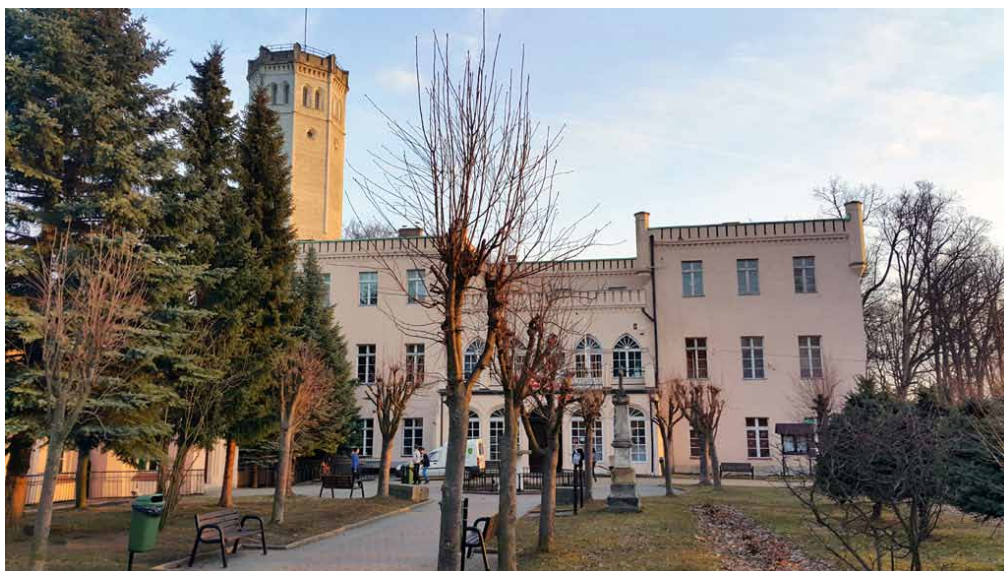
Pałac Królewski – obecnie szkoła – w Myslakowicach
