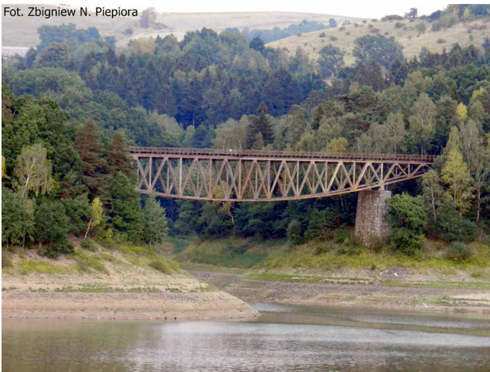
Most kolejowy nad Jeziorem Pilchowickim – (4.08.2015)
