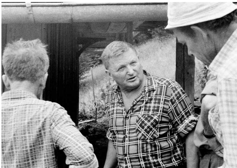
Podczas budowy schroniska na Bereśniku (1987). Fot. R.M.Remiszewski
