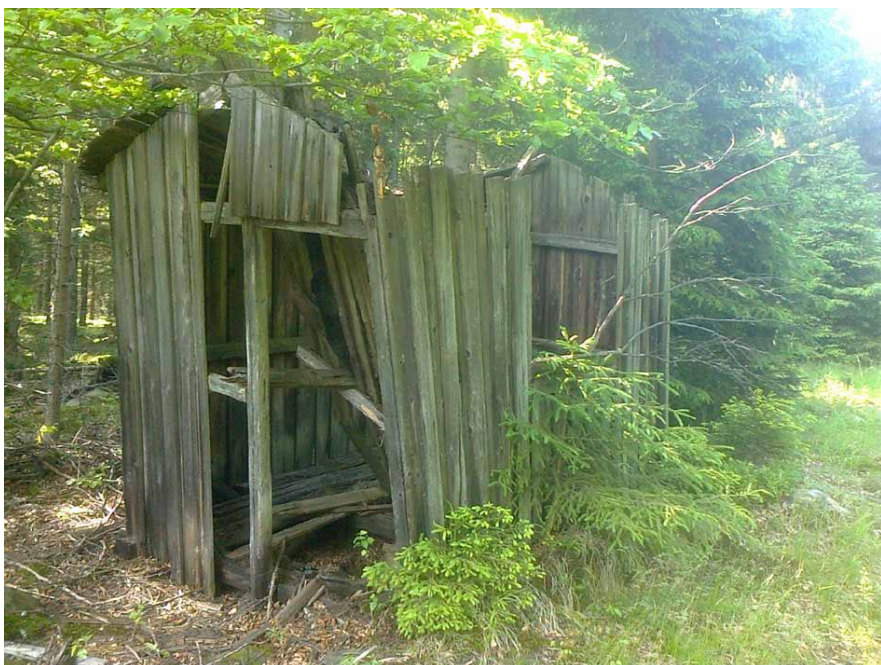
Drewniana budowla przy dolnym odcinku dawnej Maxlinie (Drodze na Bude na Saniach)
