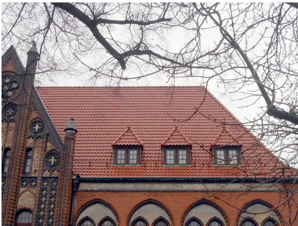
Fragment budynku przy ul. Juliusza Słowackiego 9 w Wałbrzychu
