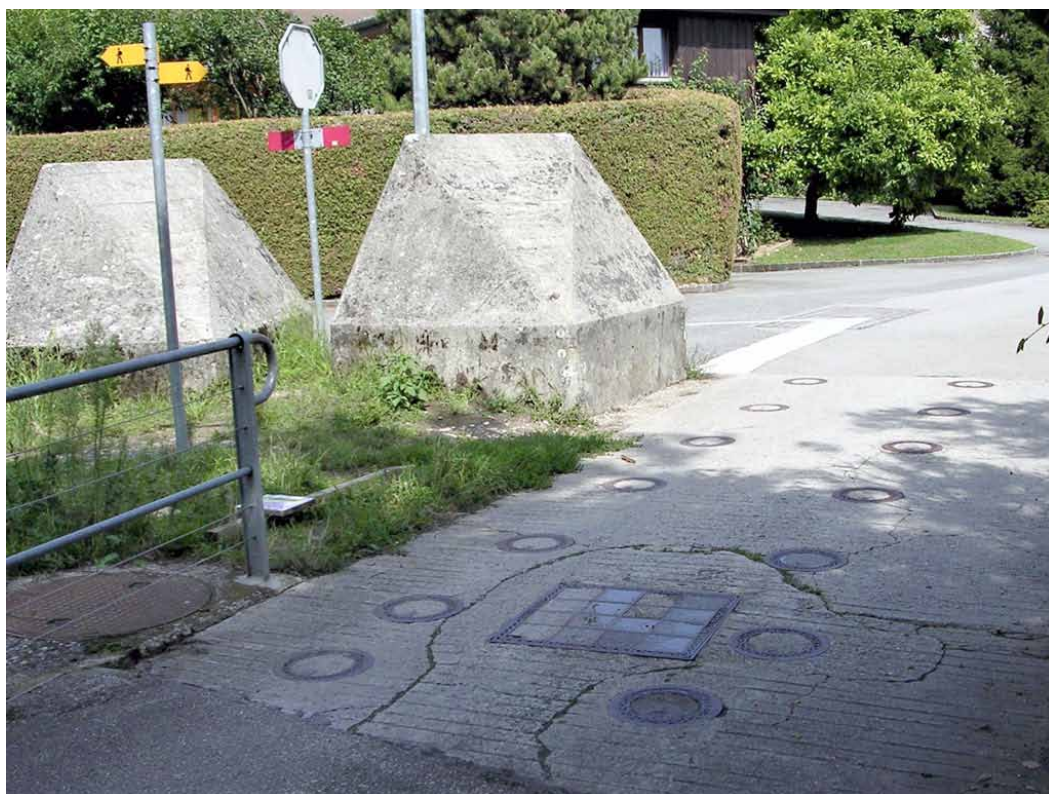
Przejście ulicy w Vich przez linię umocnień – widoczne okrągłe, zaślepione otwory do osadzania pali zaporowych
