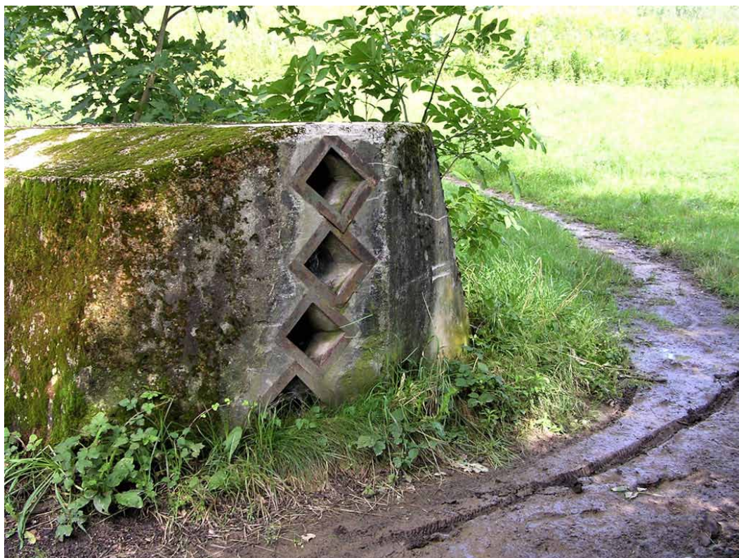
Przejście polnej drogi przez linię umocnień – widoczne otwory do osadzania poziomych belek zaporowych
