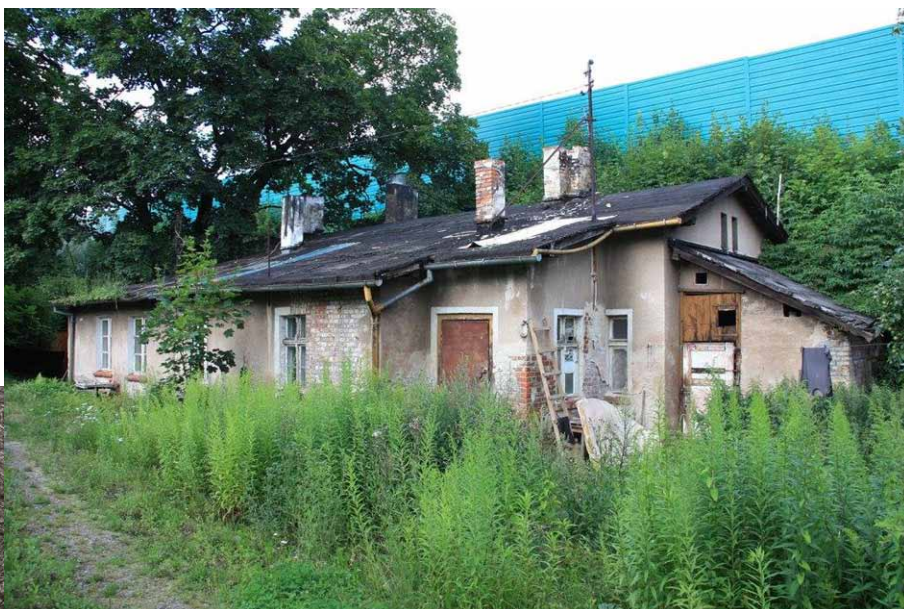
Dawny dworzec kolejowy Mały Kack
