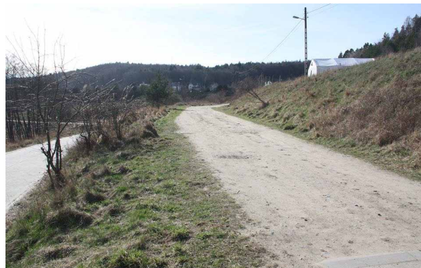
Nasyp linii kolejowej Gdynia-Kokoszki przy ul. Ornej
