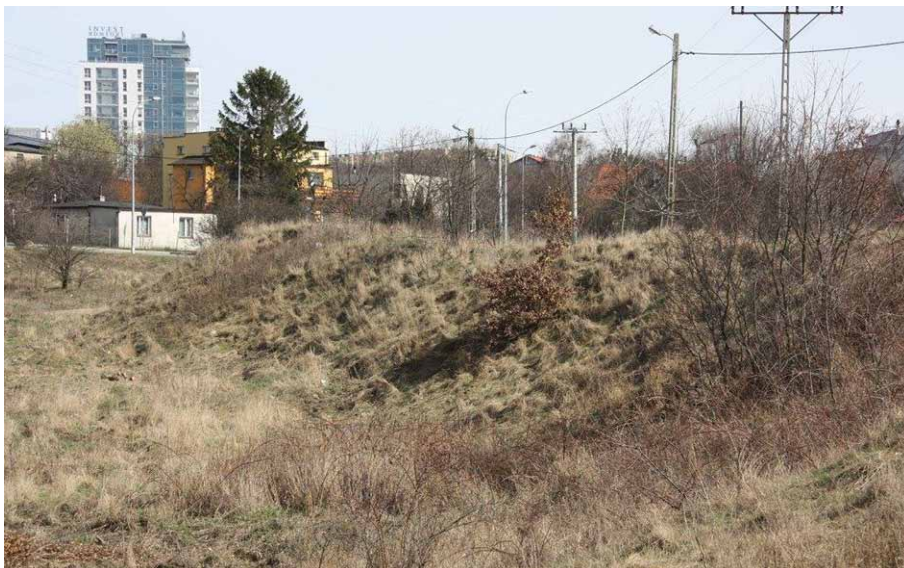
Nasyp linii kolejowej Gdynia-Kokoszki przy ul. Krośnieńskiej
