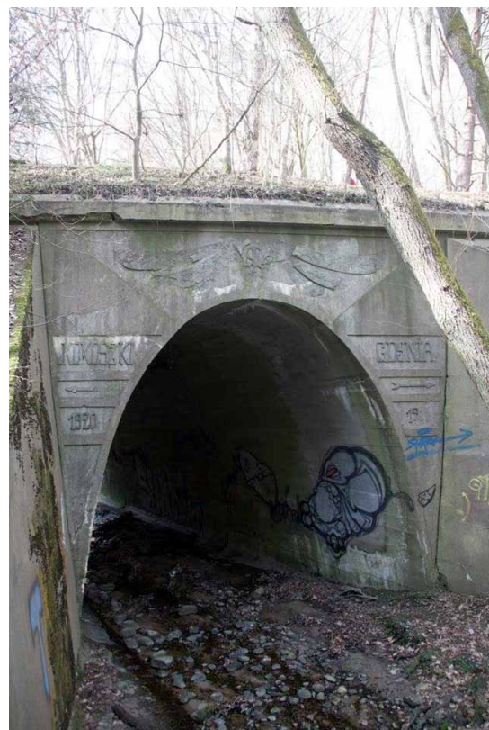
Przepust kolejowy nad strumieniem Kacza
