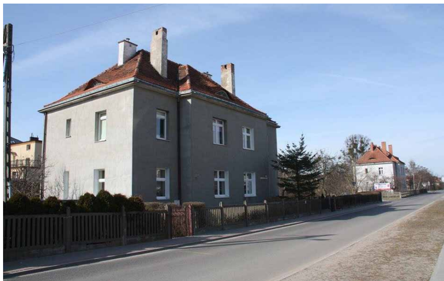
Pozostałości zabudowy pierwszej stacji Wielki Kack
