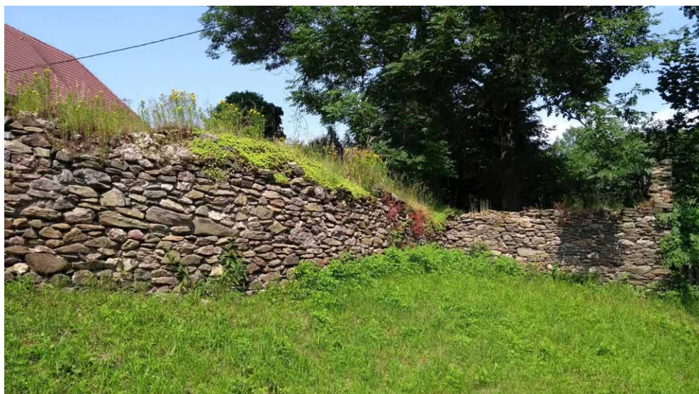
Ogrodzenie kościoła w Starych Rochowicach
