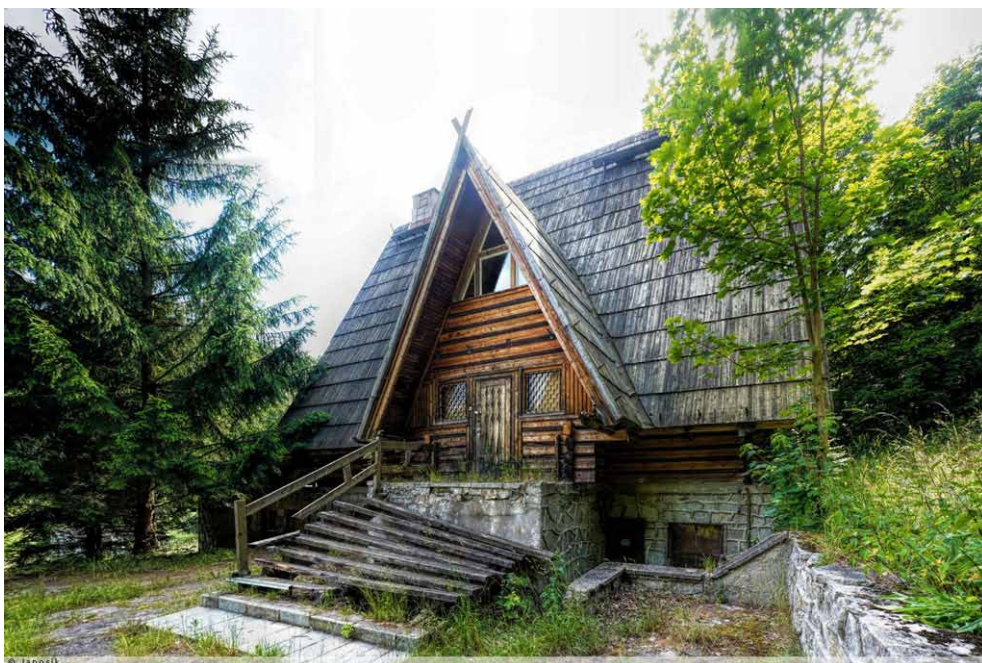
Baczówka pod Trójgarbem przed rozbiórką
