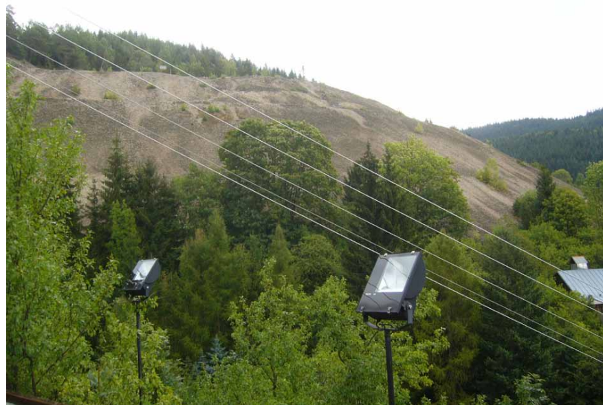
Hałda skały płonnej z eksploatacji miejscowych kopalni
