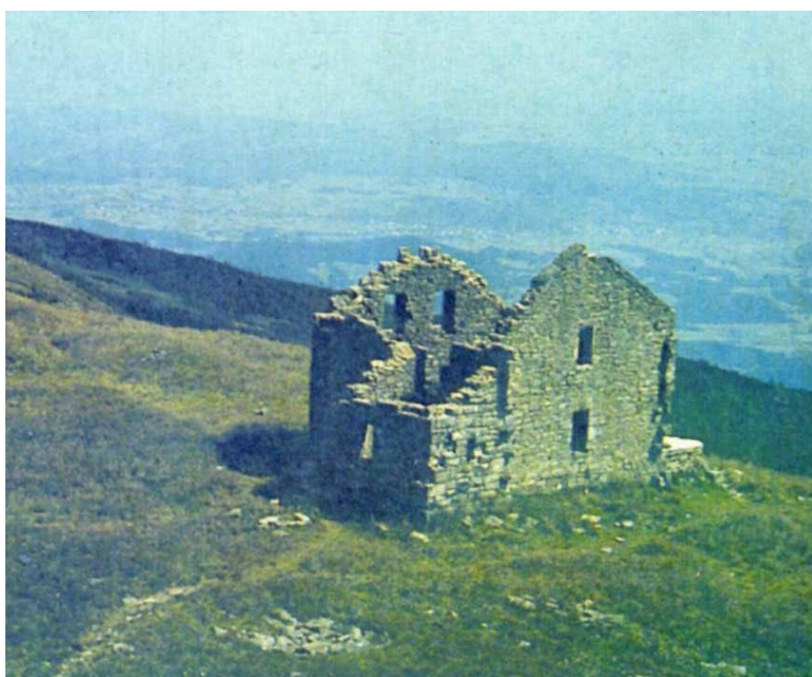
Ruiny schroniska przed zburzeniem
