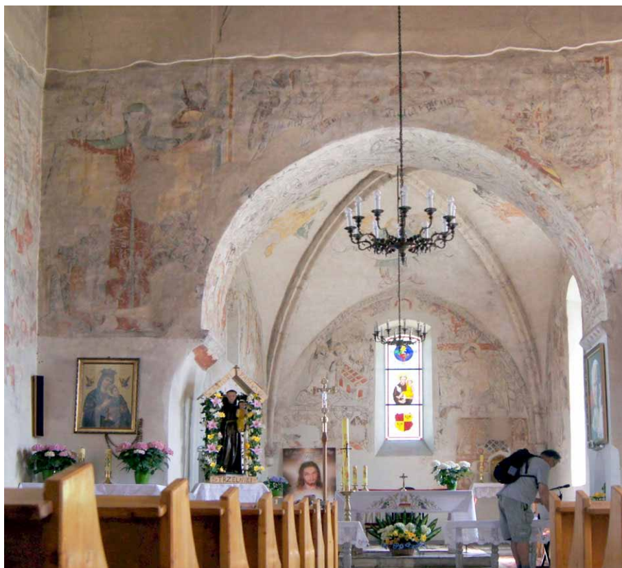
Strzelniki. Co się kryło pod tynkiem
