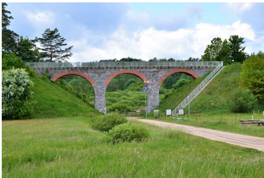
Wiadukt kolejowy w Glaznotach po remoncie z 2018 r.
