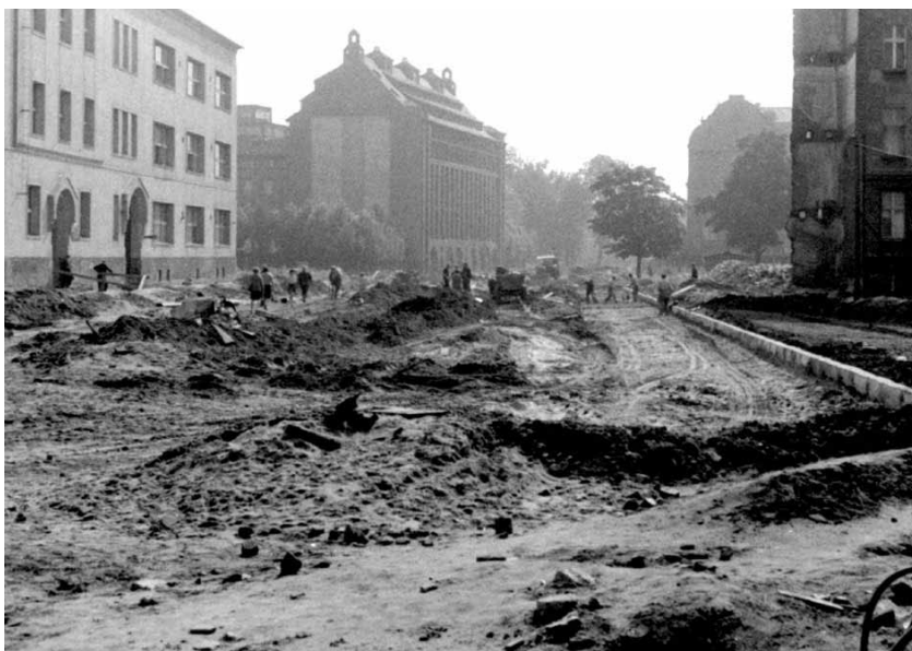
Remont ul. Sienkiewicza (czerwiec 1966)
