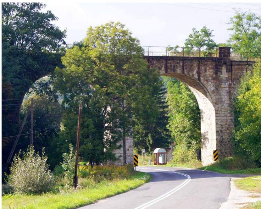
Kamienny most kolejowy nad Strzyżowcem
