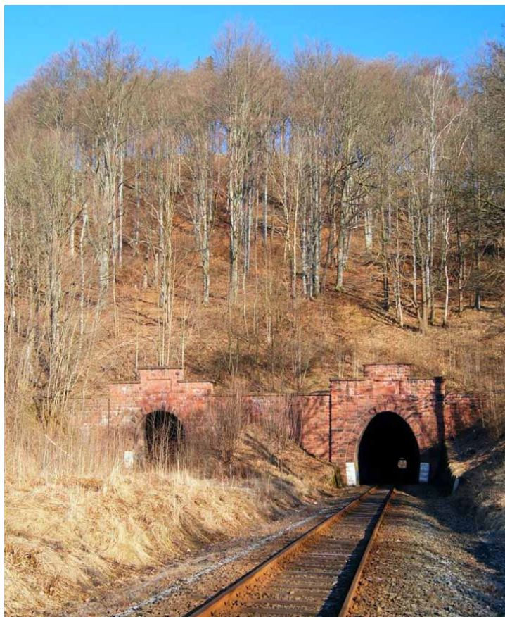
Tunele pod Sajdakiem. Przejście dla pieszych tylko komorą zachodnią
