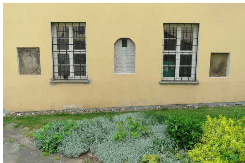
Południowa ściana dawnej plebanii
