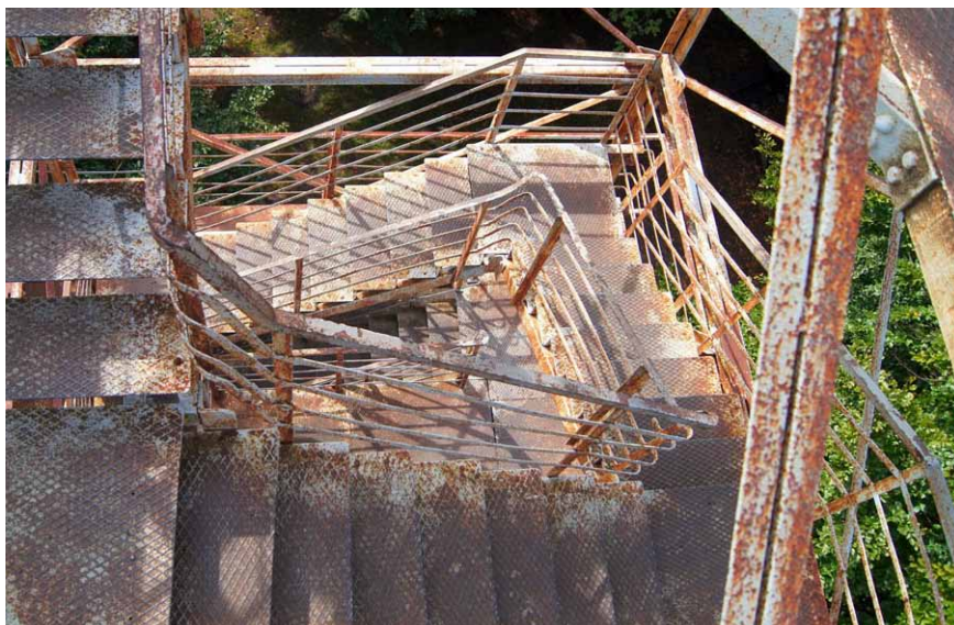
Kalenica. Wieża – stan w 2022 r., przed remontem
