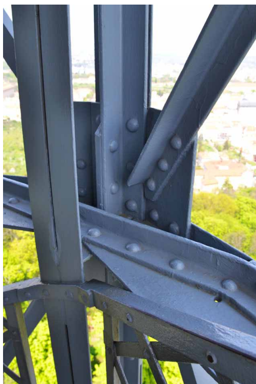
Szczegół nitowanej „na gorąco” konstrukcji wieży
