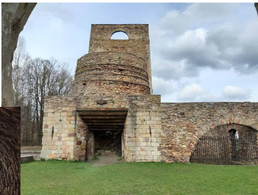
Ruiny wielkiego pieca widziane od strony odlewni
