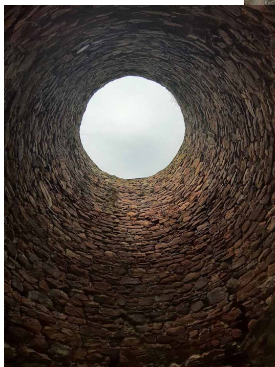
Wnętrze wielkiego pieca
