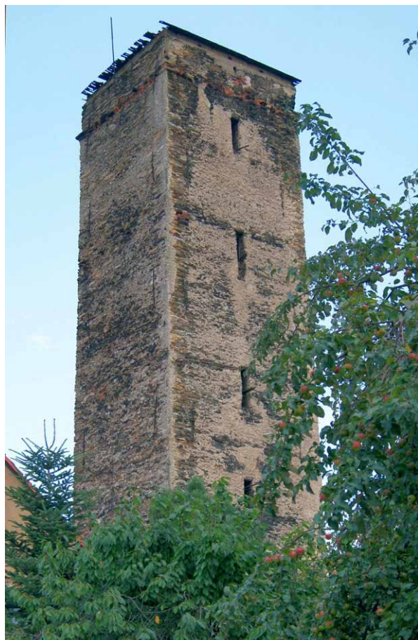
Wierzbna. Wieża wodna
