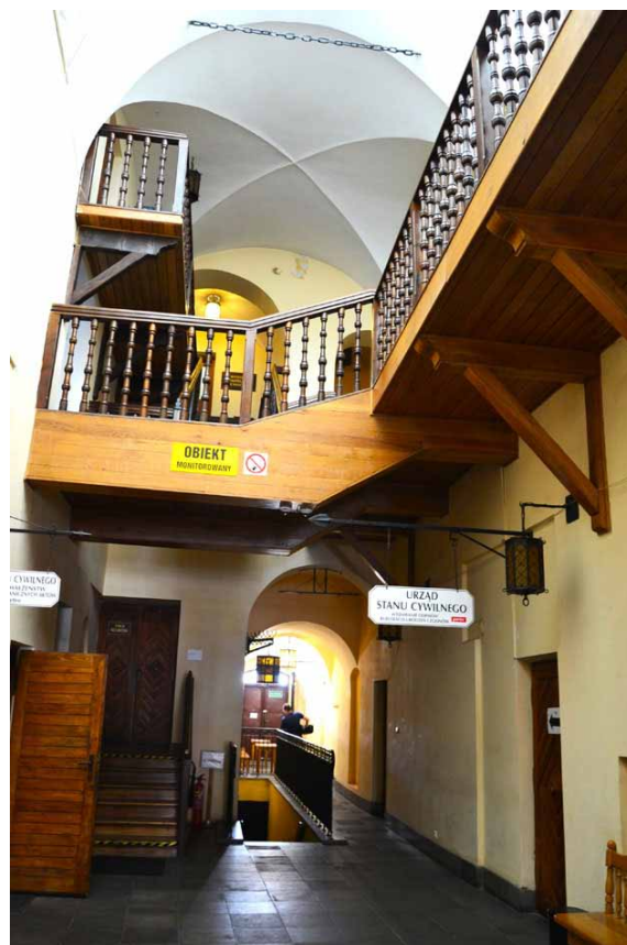
Kamienica Gruszewiczów, sień
